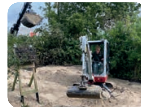
Het aanbrengen van gespoeld zand
